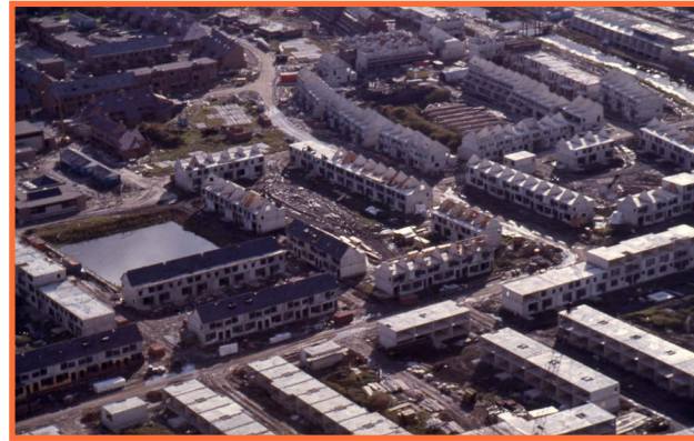
Seghwaert in aanbouw
