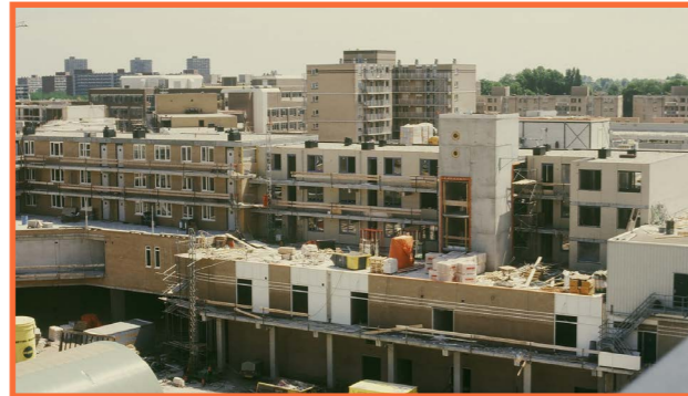
Aanleg van de Promenade
