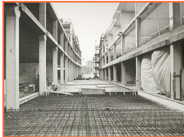
Het plaatsen van de funderingen van Westwaarts
