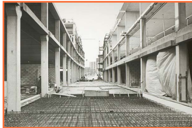
Bouw van het Stadscentrum, plaatsen fundering
