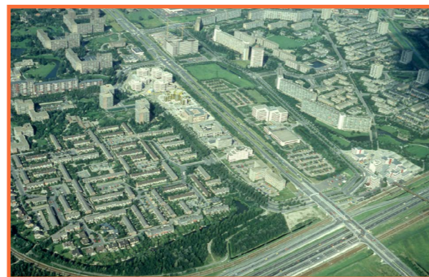
Groenstrook langs de A12 met Meerzicht en de kantorenstrook langs de Afrikaweg
