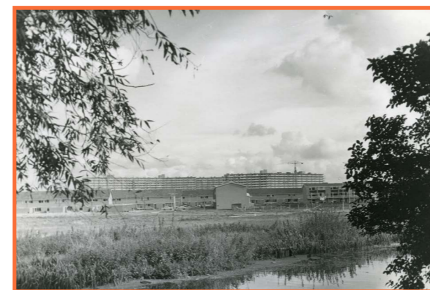
Gezicht op Palenstein in aanbouw 1966
