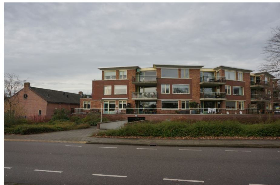
Tehuis aan de Meidoornlaan [Contreij]
