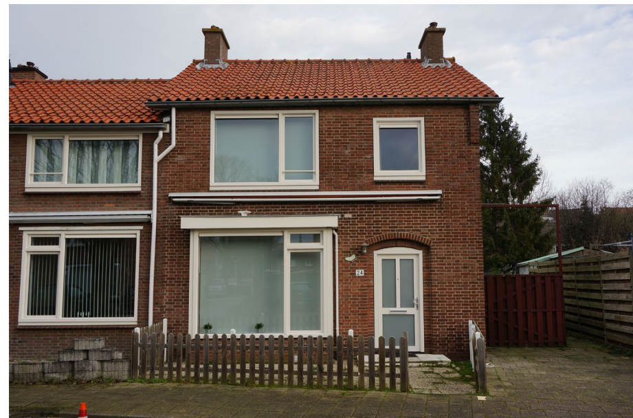
Cornelis van Eerdenstraat, een verspringende kap op de kop van het bouwblok. De houten puien zijn recent vervangen door grove kunststof exemplaren. [Contrei]
