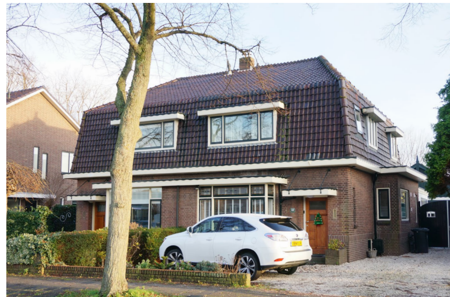
Een van de vele, royale twee-onder-een-kapwoning uit het Interbellum aan de Stationsstraat [Contrei]
