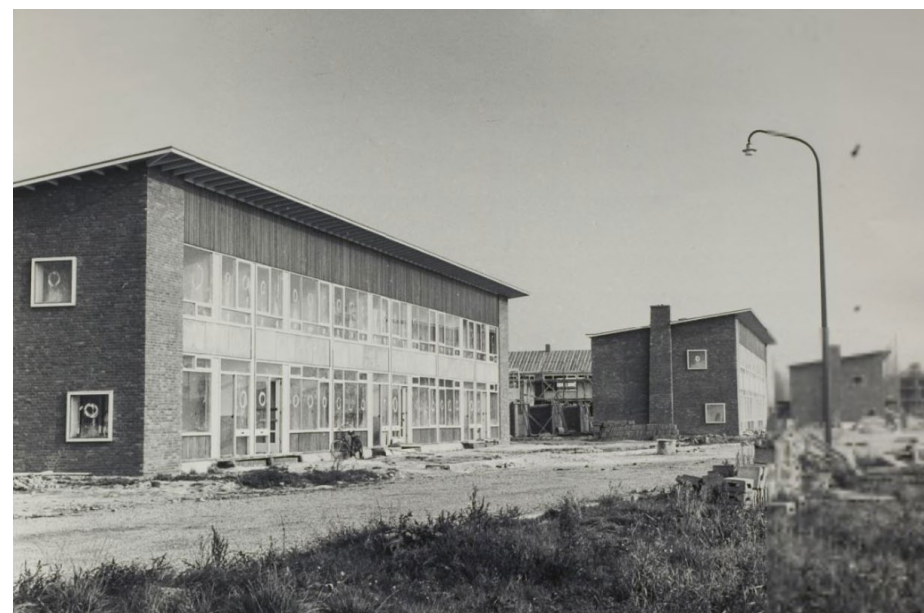
Duplexwoningen aan de Karel Doormanlaan, 1958. Inmiddels is dit project gesloopt en vervangen door nieuwbouw. [Stadsarchief Zoetermeer]
