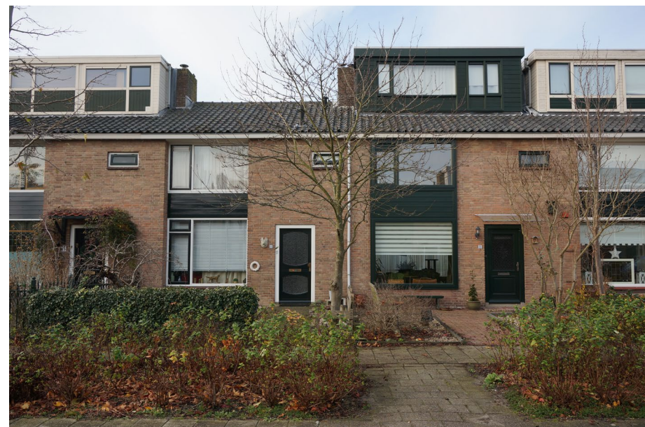
Een variatie aan dakkapellen op woningen in de Potgietersstraat in de Dichtersbuurt. [Contrei]
