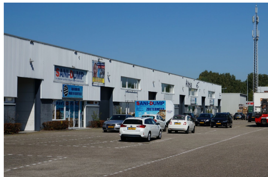
Een eenvoudig bedrijfsverzamelgebouw in Hoernerhage (1978) waarin hal en kantoor in één groot volume gecombineerd zijn. Bedrijven kunnen zich hier alleen nog met reclameuitingen onderscheiden. [Contrei]
