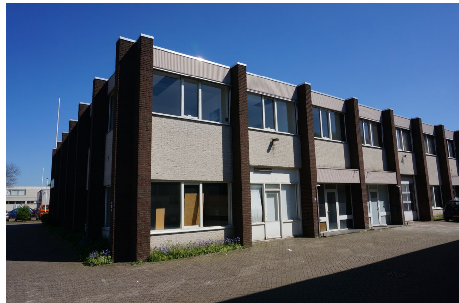
Een bedrijfsverzamelgebouw uit de late jaren '70 laat de overgang zien van traditionele bouw (metselwerk) naar systeembouw (golfplaat). [Contrei]
