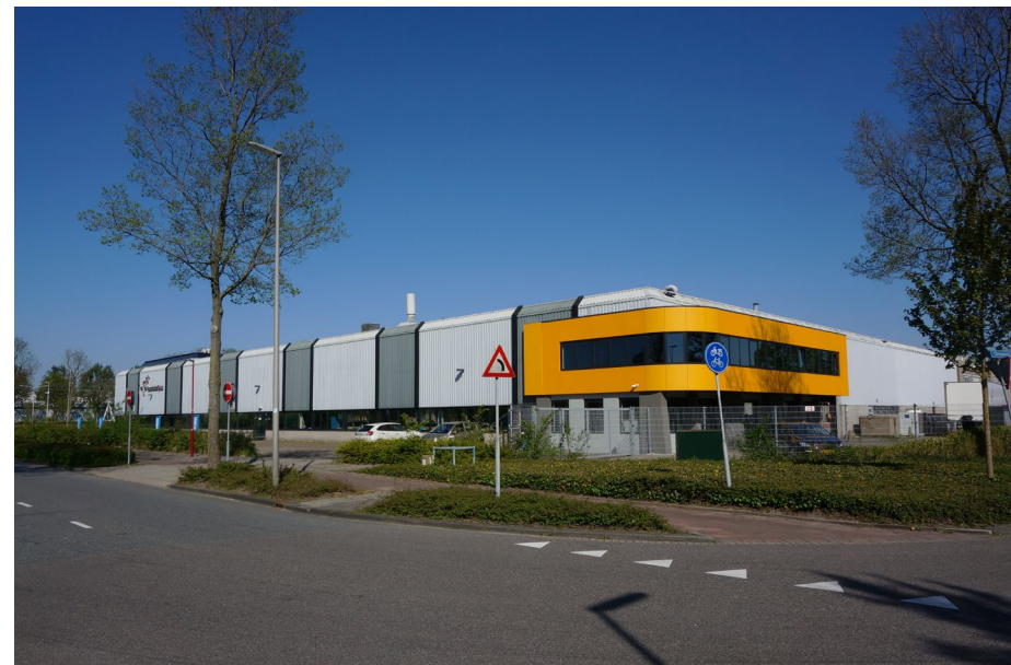
Een productiehal in Lansinghage. De grijze verticale banden maken het volume visueel kleiner en doorbreken de monotonie. [Contrei]
