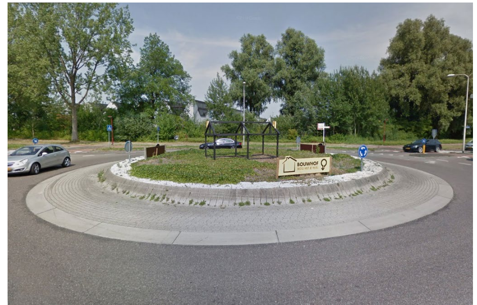
De rotonde in 2019, nu met reclame van de lokale bouwmarkt. [Google Maps/Contrei]
