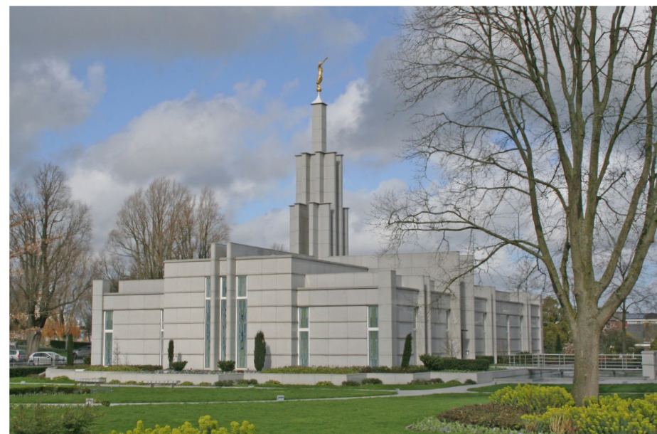
De Den-Haagtempel gelegen tussen de oude dorpskern en Palenstein-Laag [Contrei]
