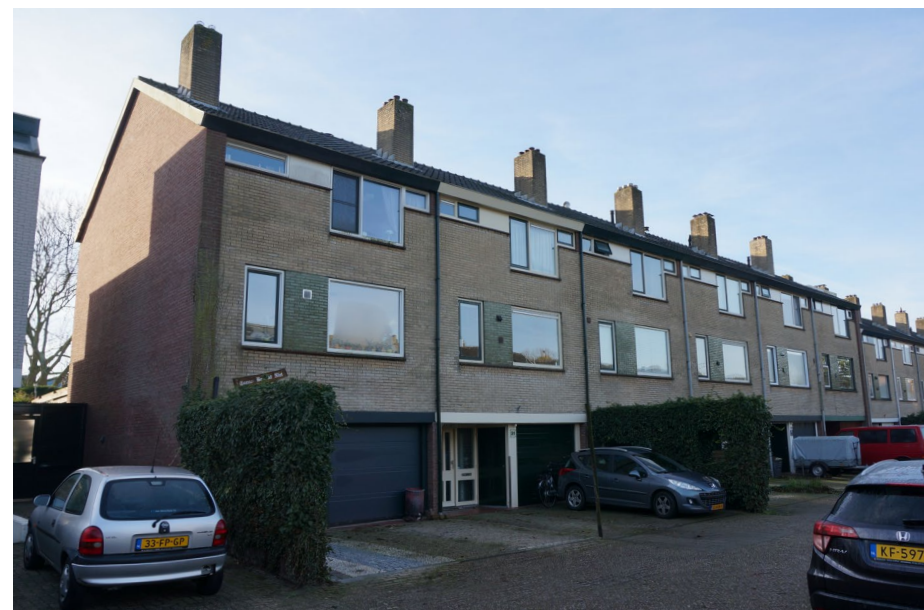
Drive-inwoningen aan de Boisotring [Contrei]
