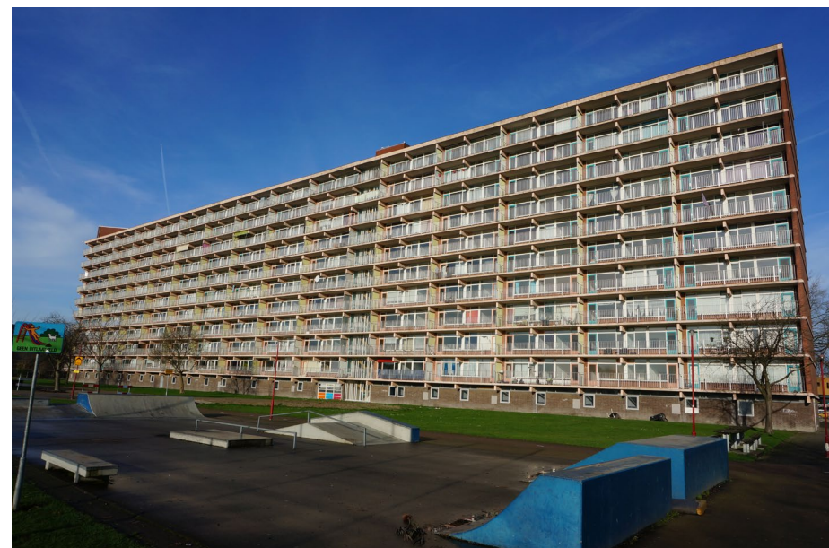
Galerijflat aan de Diederik van Teilingenlaan [Contrei]
