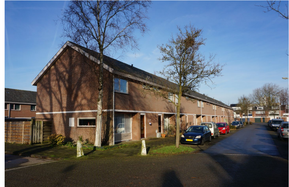
De sociale huurwoningen in Palenstein-Laag in oorspronkelijke staat [Contreij]
