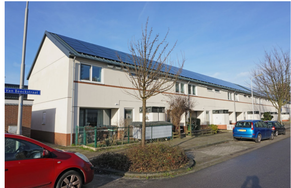
Gereneveerde huurwoningen in Palenstein-Laag [Contreij]
