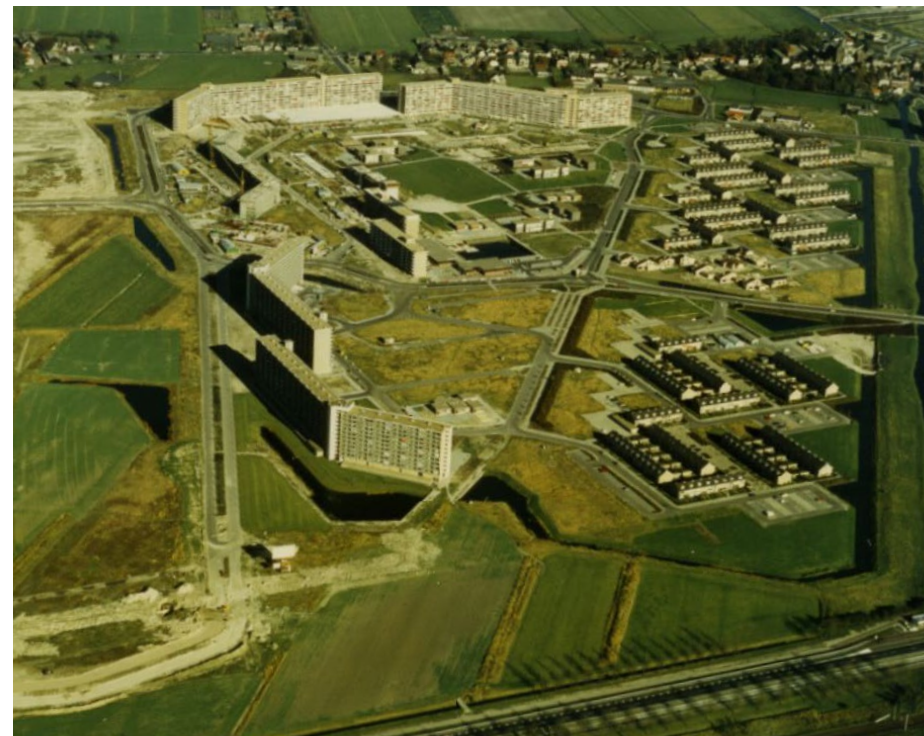
Luchtfoto van de aanleg van de wijken Driemanspolder en Meerzicht in 1971. De ring van wijkenstluitingswegen is goed zichtbaar, net als de ruimtelijke compositie van hoog- en laagbouw. De woontorens langs Delftsewallenwetering ontbreken nog. Linksboven de inmiddels verdwenen verbindingsweg tussen de Boerhaavelaan en de Meerzichtlaan. Bovenin de Voorweg-Vlamingstraat. Uiterst rechts de Delftsewallenwetering. [Stadsarchief Zoetermeer]
