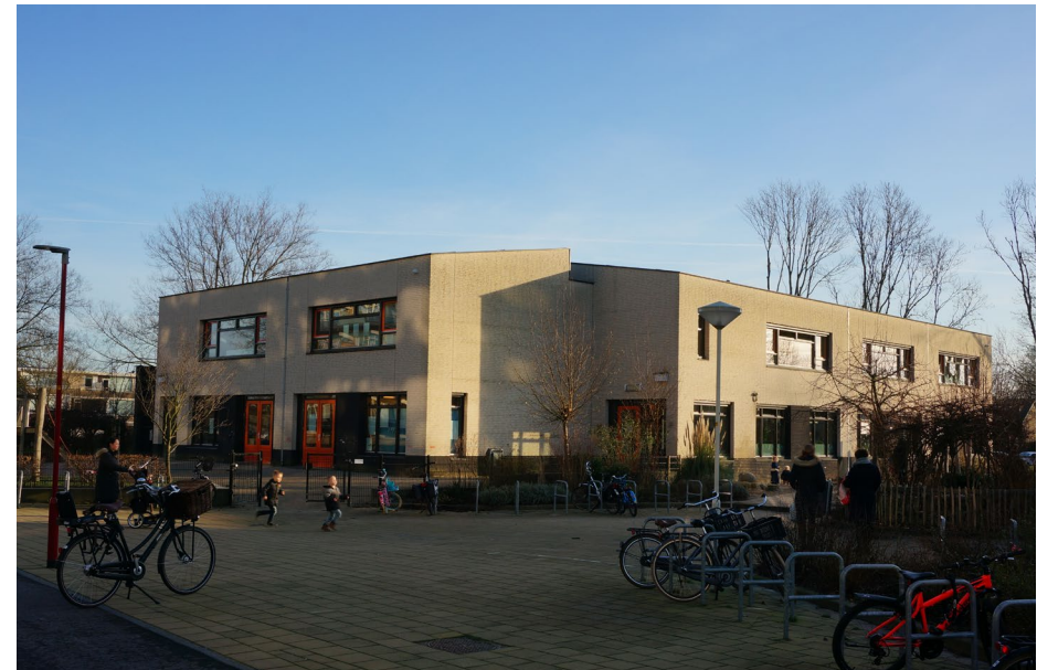
Eén van de nieuwe schoolgebouwen aan de Clauslaan/Willem Alexanderplantsoen. [Contrei]
