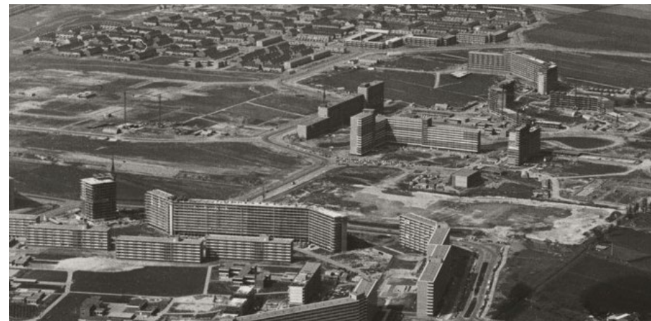
Luchtfoto van Meerzicht, begin van de jaren '70. De hoogbouw rond het Abdissenbos is in aanbouw. In de achtergrond de laagbouw van de Landenbuurt. Op de voorgrond de flats van Driemanspolder [Stadsarchief Zoetermeer]
