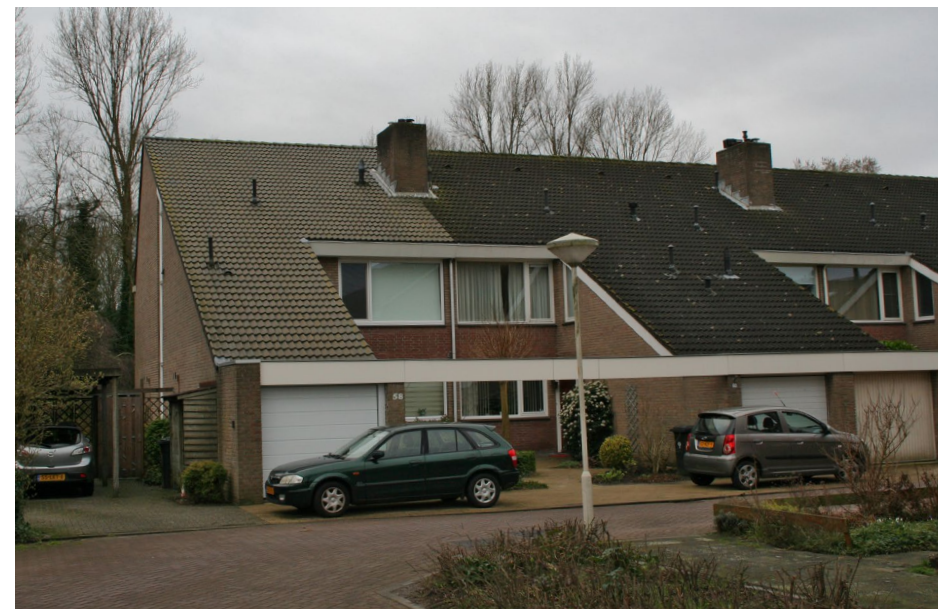
Woningen aan het Korfwater in de Waterbuurt met een opvallende doorlopende dakklijst, 2019 [Contrei]
