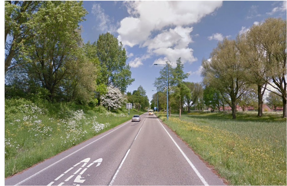
Langs een groot deel van de Aziëweg ligt een groen talud bij wijze van geluidswal. De weg wordt omzoomd door dichte bomenrijen en struweel [Google Maps]
