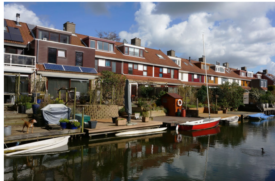
De Kadebuurt wordt omringd en doordrongen door het water van de Broekwegwetering. Dit levert veel bijzondere woonmilieus op, 2020 [Contrei]
