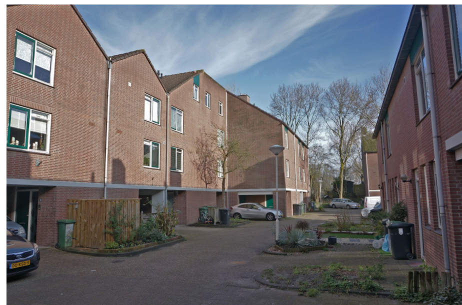
Een groot deel van de Filmbuurt bestaat uit deze compacte woningbouw met gevarieerd daklandschap, 2020 [Contrei]
