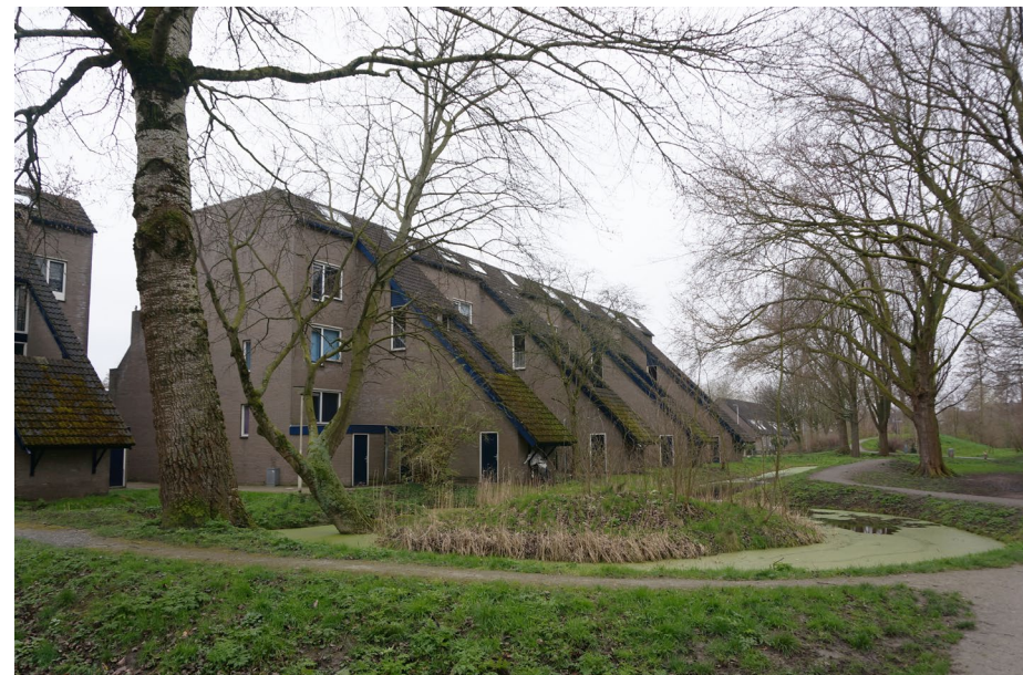
Het Seghwaertpark kent vier ruimtelijke thema's, één daarvan is de 'beek' die gevoed wordt door het regenwater van de Pluviometer, een appartementencomplex met zeer lange, steile, schuine daken [Contrei]
