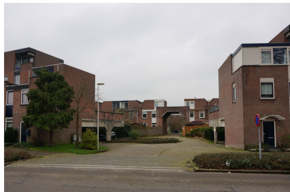
Een poort in de bebouwingswand langs de Parkdreef. Deze route voor voetgangers en fietsers leidt van de rand van de buurt naar het hart, en staat haaks op de route voor auto's.. [Contrei]
