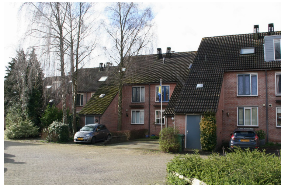
Woningen aan de Vlasakker met vooruitgeschoven bergingen waartussen ruimte ontstaat voor (groene) voorerfjes die vloeiend overgaan in de openbare ruimte [Contreij]
