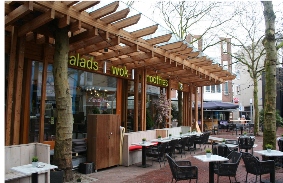
De ontwikkeling van het stadshart gaat nog altijd door: aan het burgemeester Wegstaplein is in 2016 een horeca-paviljoen gebouwd [Contrei]
