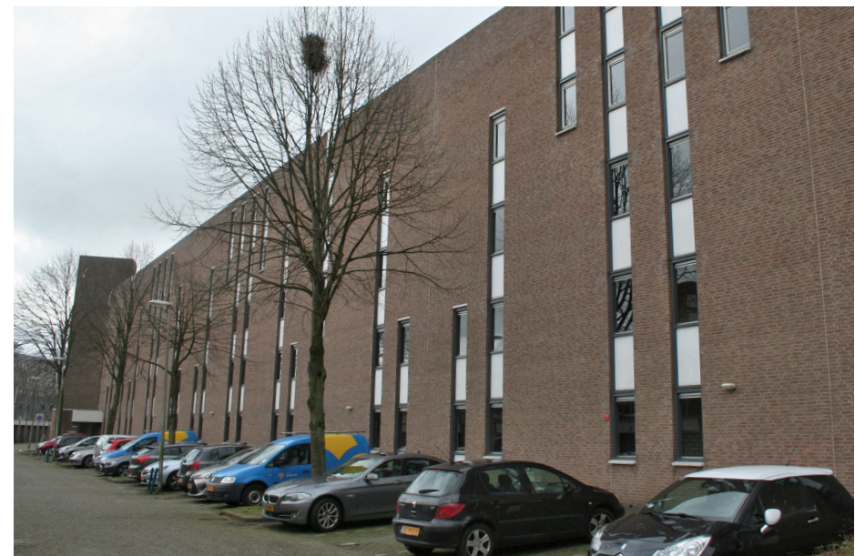
De terrasflat aan de Reimsstraat fungeert als geluidsmuur voor de Zoetermeerlijn. De achterzijde is dan ook vrij gesloten [Contrei]
