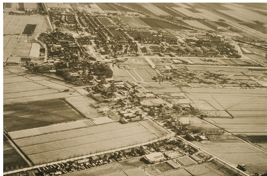
Luchtfoto uit ca. 1965 van de oude dorpskern. De driehoek van de wijk Dorp is goed zichtbaar, de wijk Driemanspolder is in aanbouw. De weg links onder is de oude Broekweg [Stadsarchief Zoetermeer]
