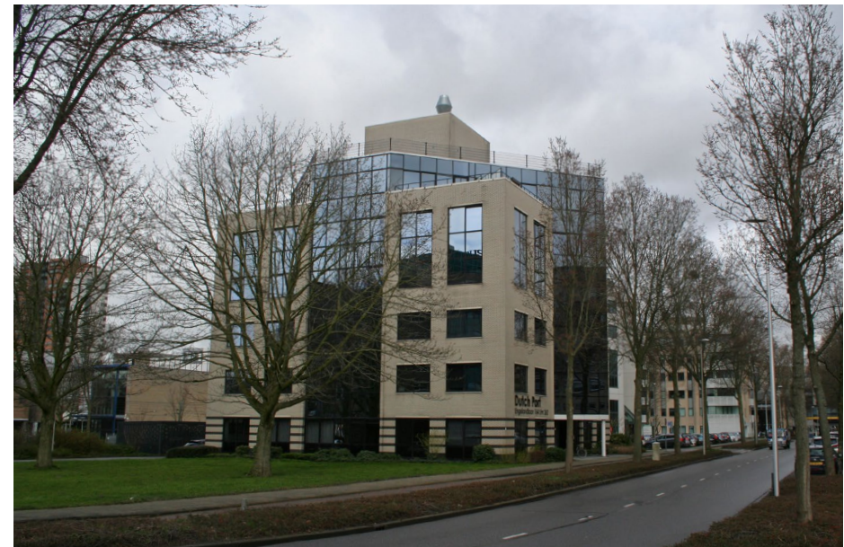
In de Engelse buurt staan een aantal kantoorvilla's waarvan een deel inmiddels is omgevormd tot appartementencomplex [Contrei]
