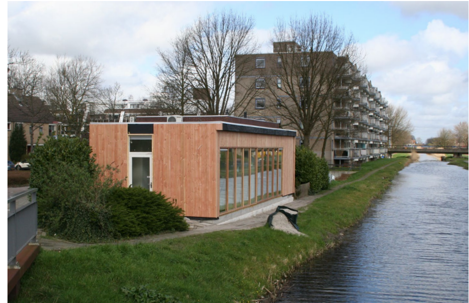
De (uitbouw) van de tandartsenpraktijk en het appartementencomplex aan de Osyiaan staan pal tegen de Leidsewallenwetering aan. Het voetpad, een waardevolle recreatieroute, krijgt het karakter van een achterpad [Contreij]
