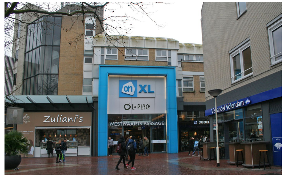
De markering van de Passage Westwaart is meer onderdeel van de reclame-uitingen dan van de architectuur [Contrei]
