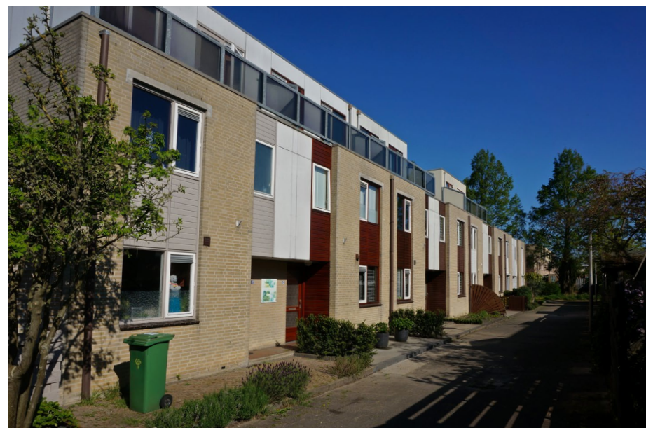
Geschakelde woningen aan de Gaudilijn. De gevelpanelen bestaan deels uit rabatdelen en deels uit trespa-panelen. De houten delen zijn veelal geschilderd [Contrei]
