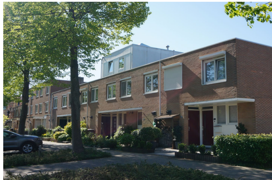
Op de rijwoningen van architect Carel Weeber worden twee verschillende dakopbouwen toegepast: in metselwerk en met het nieuwe materiaal trespa [Contrei]
