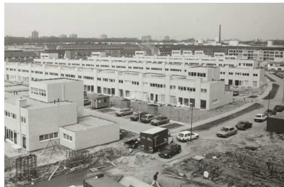
Woningen aan de Geel-groenlaan in Rokkeveen-Oost in aanbouw. Op de achtergrond zijn nog net de skyline van Driemanspolder en de schoorsteen van Nutricia zichtbaar. [Stadsarchief Zoetermeer]
