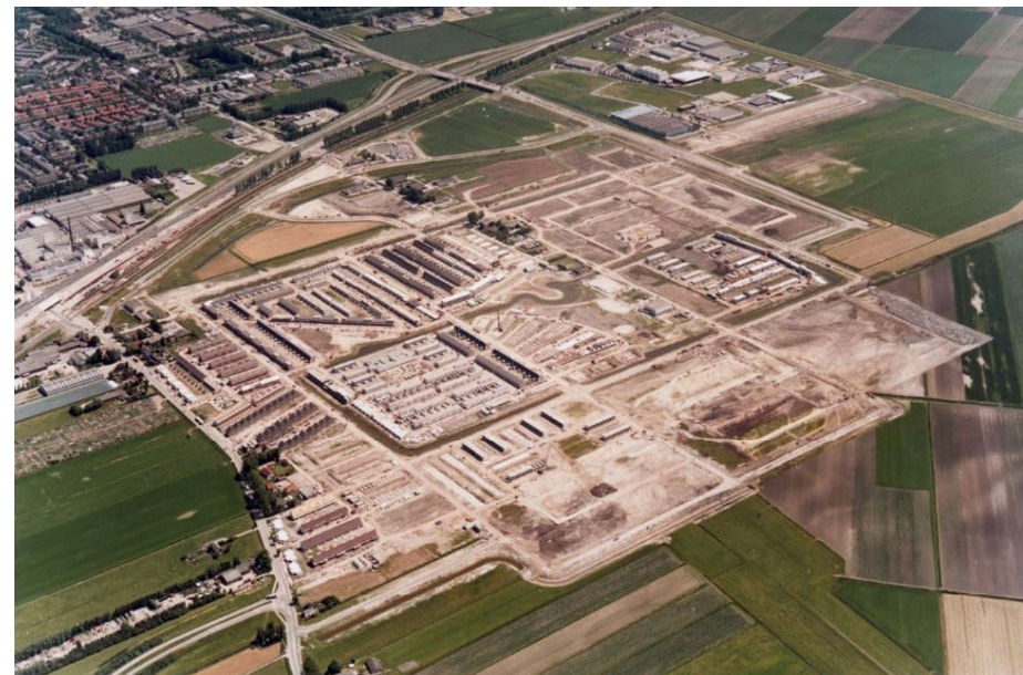
Luchtfoto van de aanleg van de Kleurenbuurt in 1988. Het grote carré en de singels zijn al goed zichtbaar. Boven in beeld is Lansinghage in aanbouw [Stadsarchief Zoetermeer]
