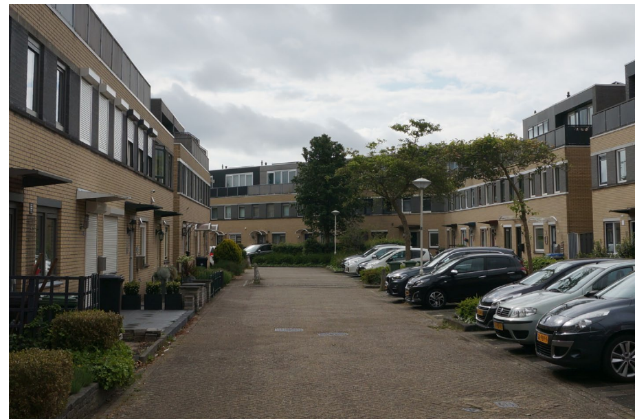
De woningblokken-met-hoekverdraaiing tussen de Groen-blaauwlaan en Reigersblauw vormen een variatie op de monotone verkaveling in Rokkeveen-Oost [Contrei]
